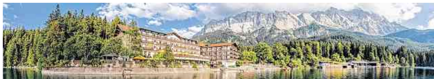
Das Eibsee-Hotel liegt auf einer Höhe von 1000 m über dem Meeresspiegel am Fuße der Zugspitze.
